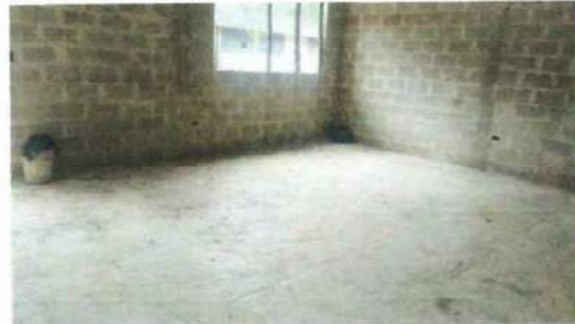
Foto 2: la Cocina en su interior necesita su colación de piso ceramico, una mesa de concreto, su polletón y su instlación eléctrica
